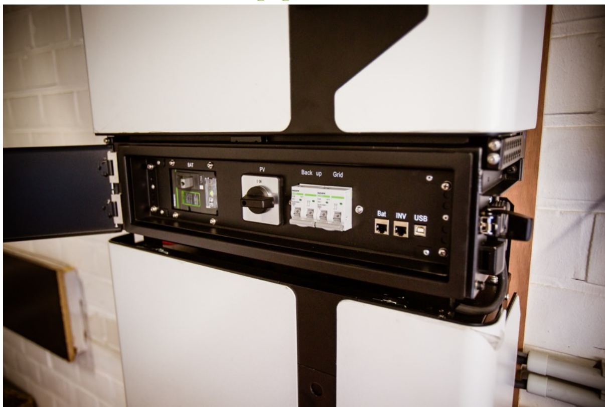
Afbeelding 8 Vooraanzicht schakel box thuisbatterij
